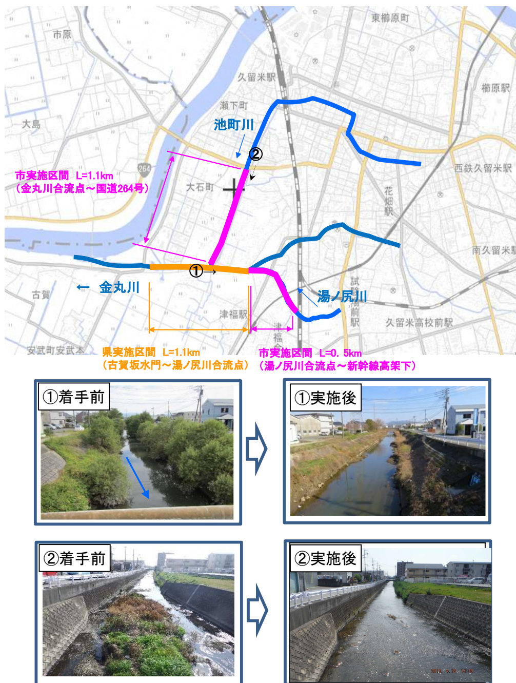
図 4-20 金丸川・池町川における河道内の土砂掘削等(平成30年7月豪雨後対応)
