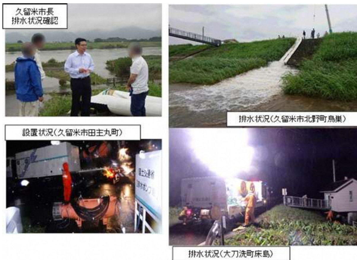
図 4-39 H30 年 7 月豪雨における排水ポンプ車等の派遣状況
