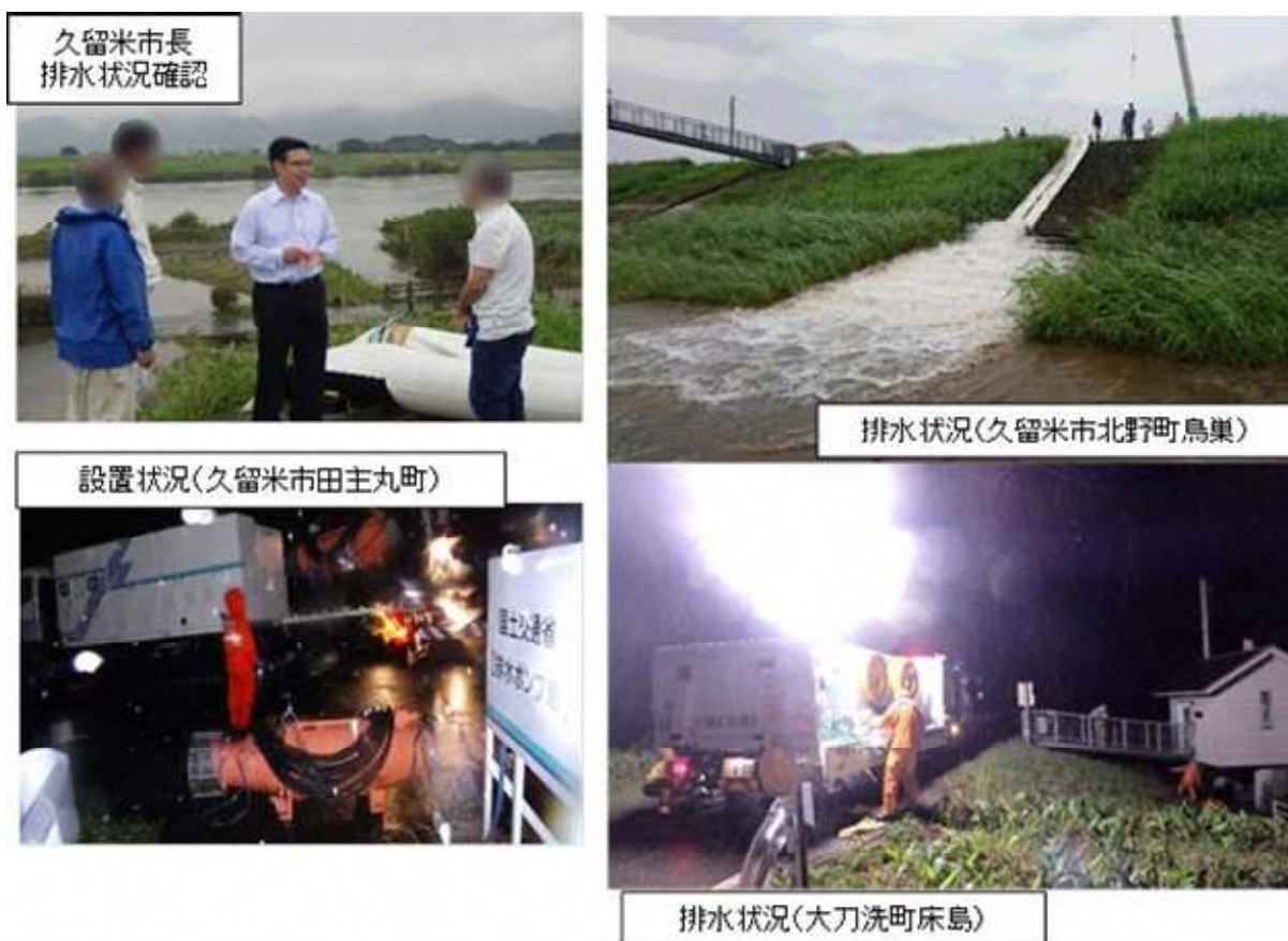
図 4-33 H30 年 7 月豪雨における排水ポンプ車等の派遣状況
