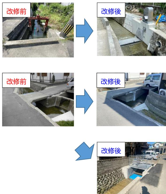
写真 4-8 水門改修状況(着工時→完了)
