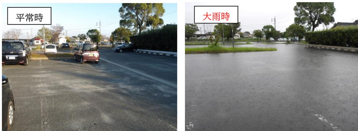
写真 4-9 流域貯留施設(オンサイト)の整備状況(城島総合文化センター)
