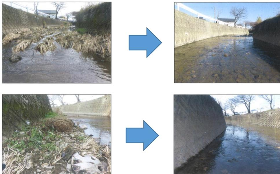
写真 4-1 堆積土砂撤去状況(支川の実施例)
