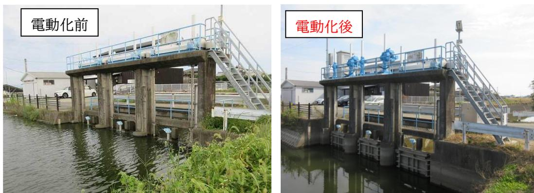
写真 4-7 水門電動化の整備状況(十郎丸制水門)
