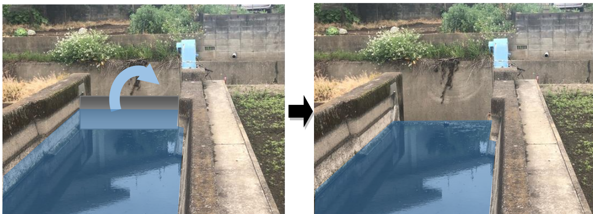
図 4- 31 用排水調節器の改良イメージ
