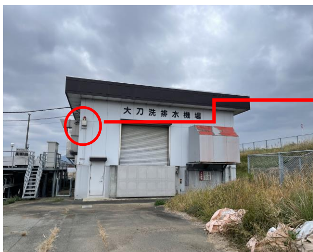
写真 4- 7 回転灯の設置状況
