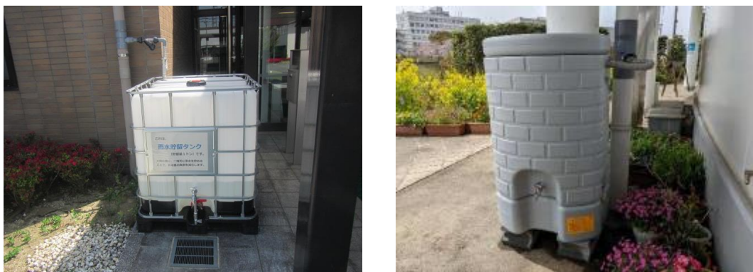
写真 4- 10 公共施設への雨水貯留タンク設置状況
