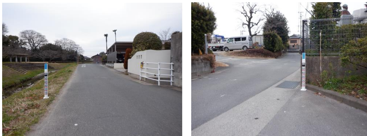
写真 4- 11 水位標設置状況
