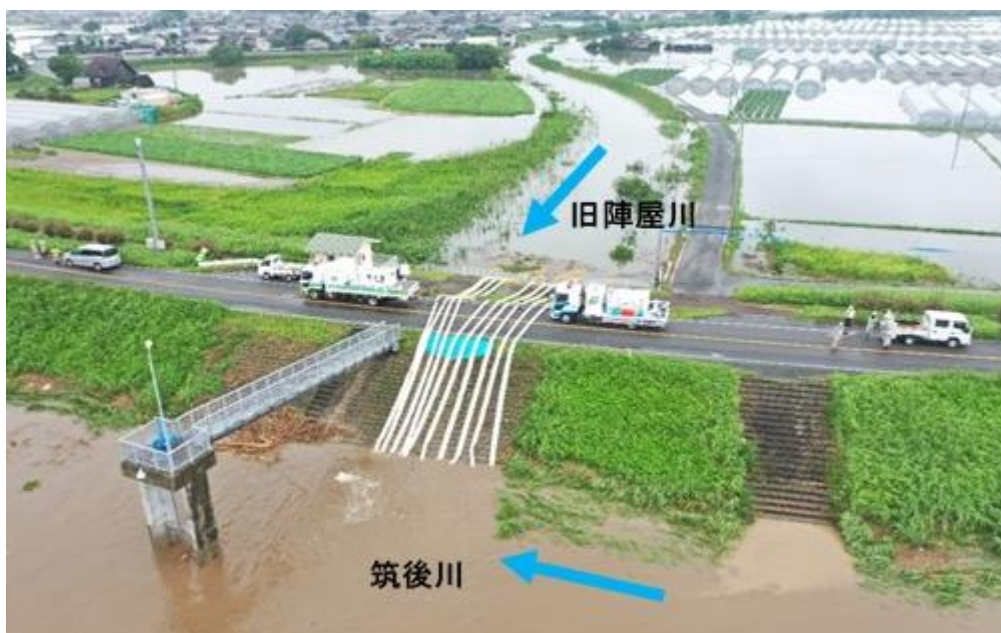
写真 4- 8 排水ポンプ車の活用状況
