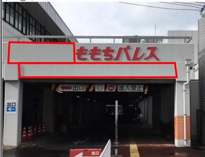
(No.⑤) 東側駐車場入口上部
