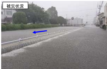
池町川(浸水) 久留米市
