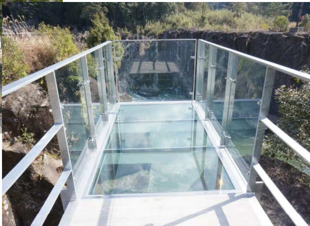
三面ガラス張り (スカイウォーク)
