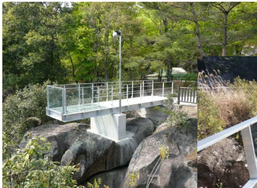
放水口の看視架台
