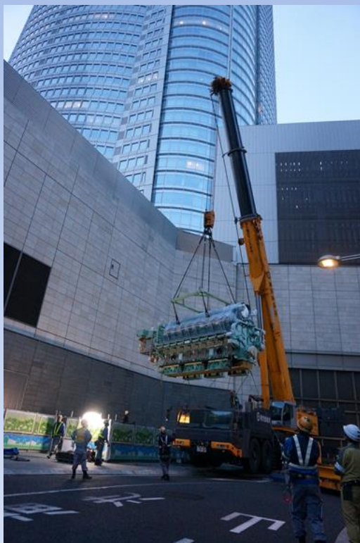
2016年5月20日早朝 ガスエンジン1号機搬入
