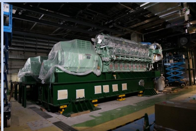
ガスエンジン+発電機 2組据付完了
