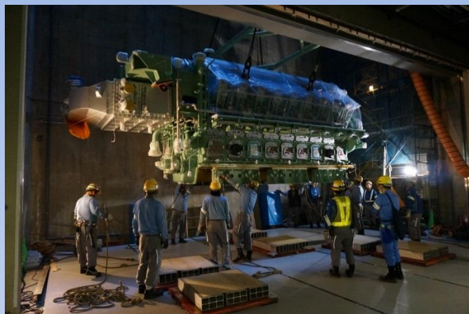
ガスエンジン(60トン) マシンハッチ吊下
