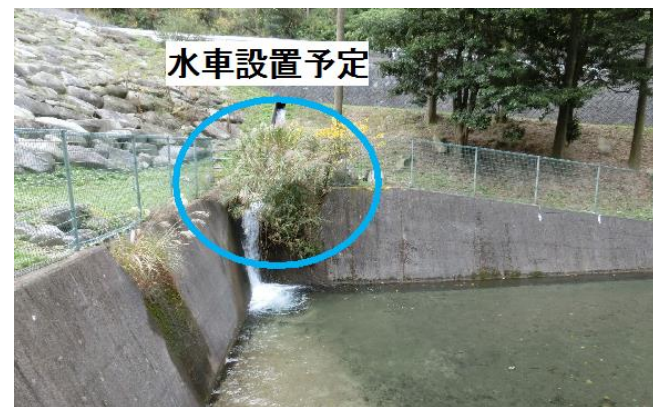
水車設置予定地
