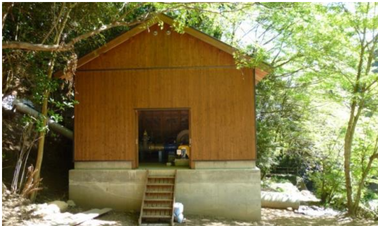
白糸の滝小水力発電所
