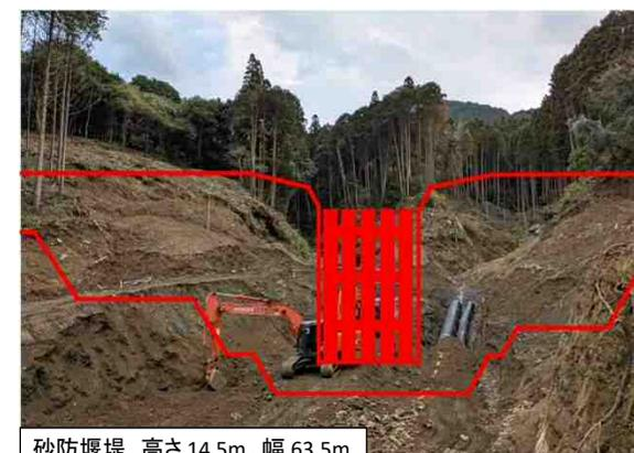
砂防堰堤 高さ14.5m、幅63.5m
