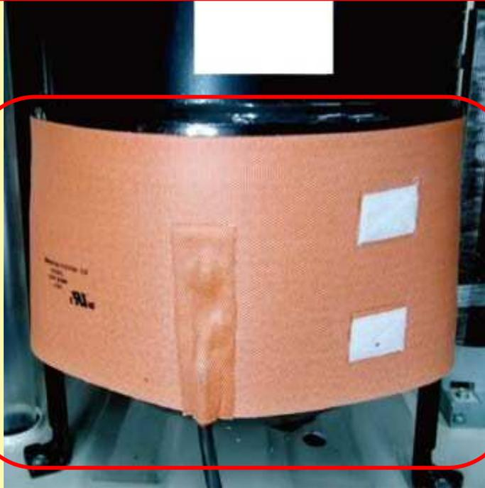
アキュムレーターにベルトヒーターを巻いて加熱します。
