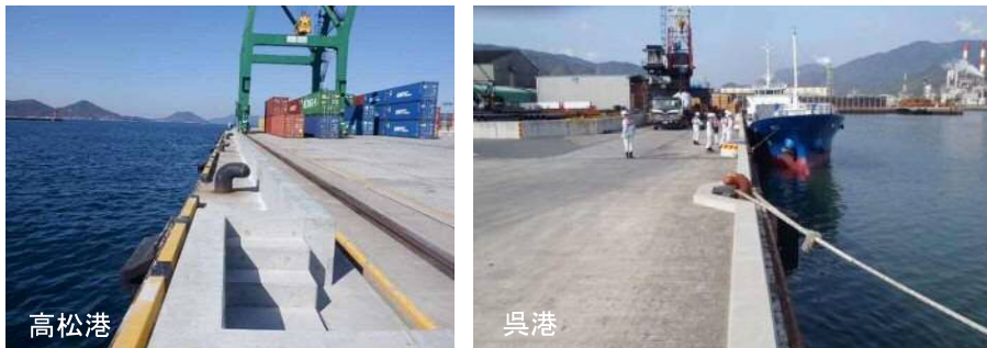
図 6.44 既存施設を活用した潮位上昇への対応例（岸壁天端の嵩上げ）
