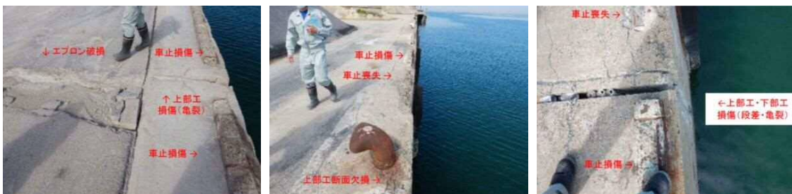
図 6.46 南港 4 号岸壁(-4.5m)の劣化状況図
