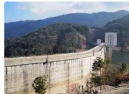
ダムサイクリング④新たな聖地・五ヶ山ダム
