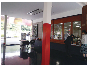
フロアの真ん中にある柱に赤いペンキを塗って目立たせ、衝突を防いでいます。
