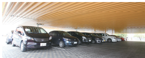
駐車場から通用口まで続く屋根を付けたら、車いすでの自家用車通勤も安心です。
