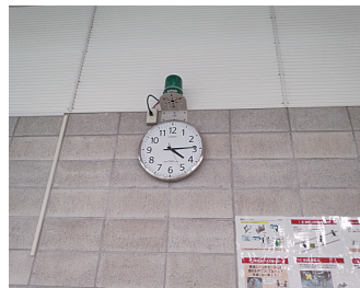
チャイムと同時に視覚で始業、就業、休憩時間を知らせるバトランプ
