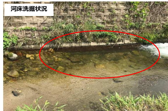
普通河川 大谷川 (福岡市早良区)
