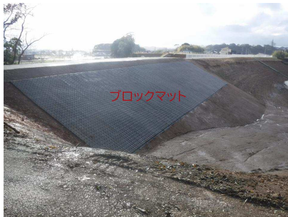
池上池 堤体改修写真
