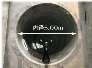
中部2号幹線最下流部
