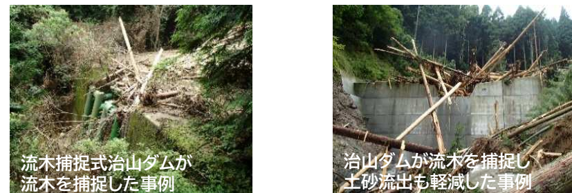
治山事業の実施による流木・土砂の流出抑制効果
