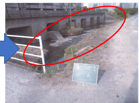
伐採・浚渫後②
