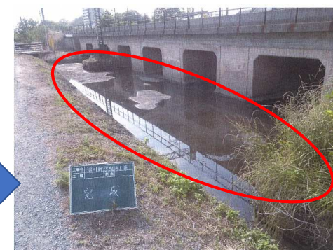
伐採・浚渫後①
