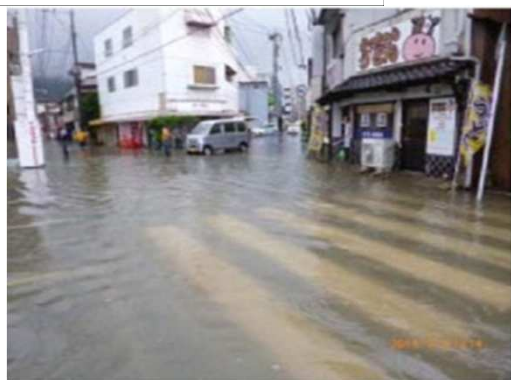
H25年7月豪雨による被害状況
