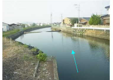
蔵丸橋より下流の状況(護岸工事後)
