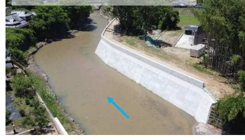
【引堤工(荒尾市本井手地内)】
