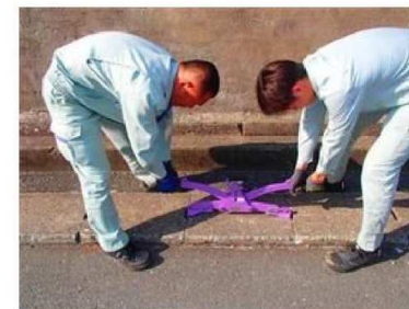
側溝蓋に取り付け
