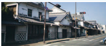
⑦筑後吉井白壁の町並み (うきは市)
