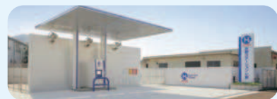
水素ステーション
