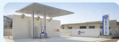
水素ステーション
