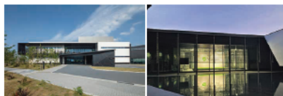
(左)創立100周年を記念し、茨城県つくばみらい市に新設した高砂熱学イノベーションセンター (右)木質チップを利用する40kW相当のバイオマスコージェネシステム2基を主力電源に採用した
