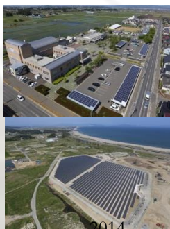
2014 民間投資によるメガソーラと同時 整備したカーポートソーラ
