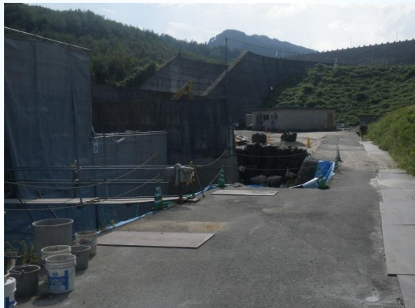
建屋部～取水部を望む
