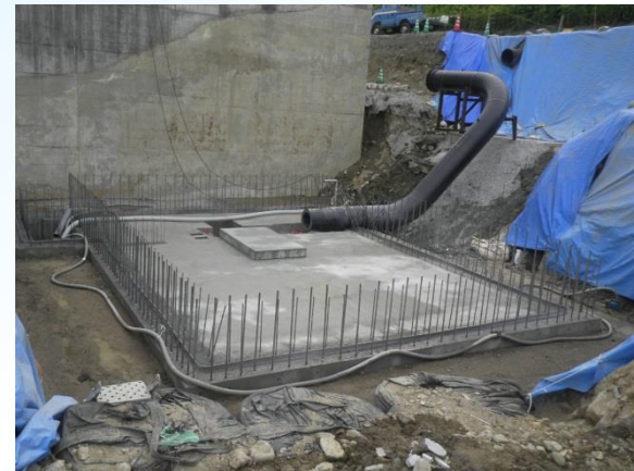
建屋（水車）付近
