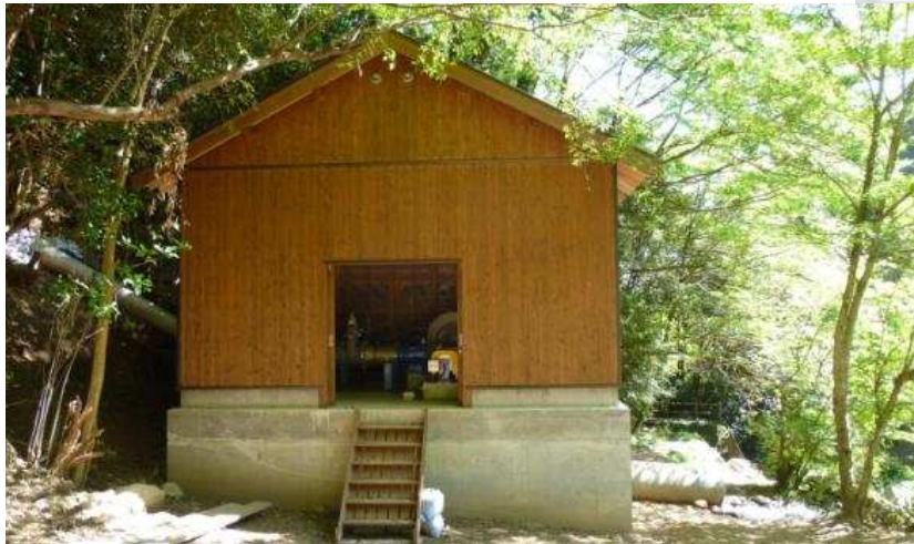
白糸の滝小水力発電所
