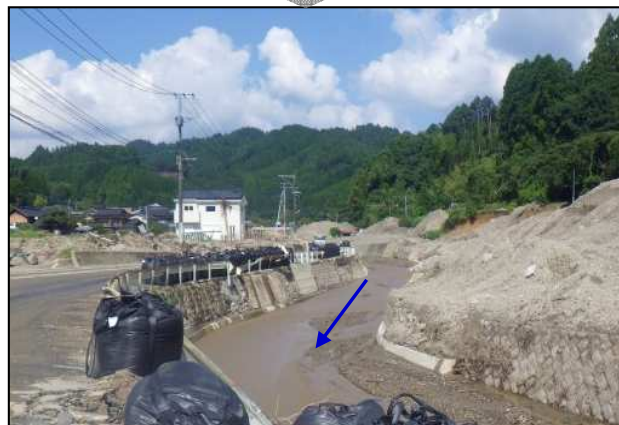
応急復旧 (継続)
