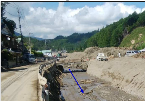
応急復旧 (継続)
