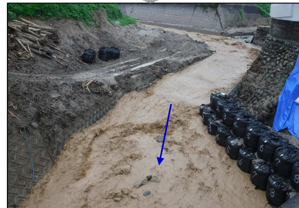
応急復旧 (継続)
