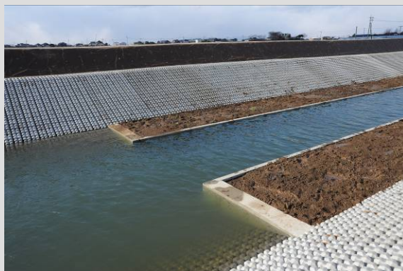
アサザに配慮したクリーク改修状況
