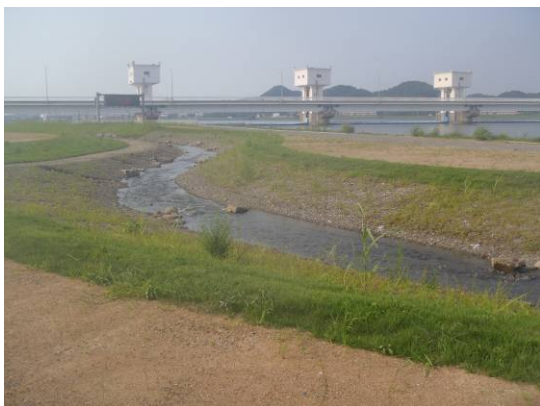
遠賀川河口堰に設けられた多自然魚道。様々な川の生きものがのびやすいように工夫された魚道です。専門家や地域住民の意見を取り入れて造られました。魚道内では多くの回遊性魚類が確認されています。
