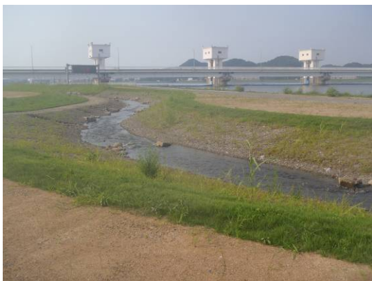
遠賀川河口堰に設けられた多自然魚道。様々な川の生きものがのびやすいように工夫された魚道です。専門家や地域住民の意見を取り入れて造られました。魚道内では多くの回遊性魚類が確認されています。
