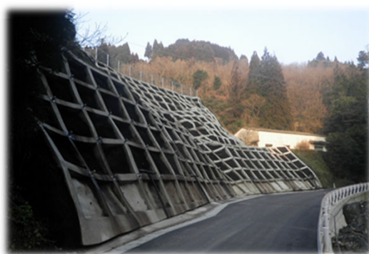
道路の改良復旧工事
