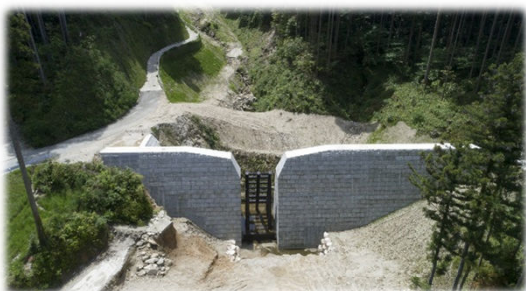
砂防ダムの設置
