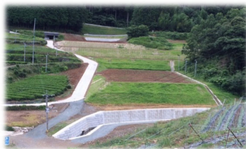
農地・農業用施設の復旧工事
