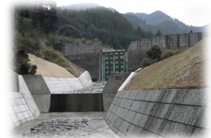
<砂防ダムの設置>
