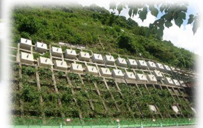
<道路法面の崩壊対策>
