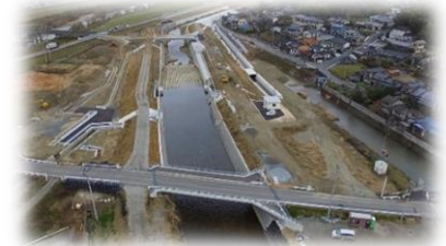
<河川の改良工事>
