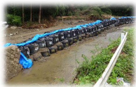
<土のうの設置>
