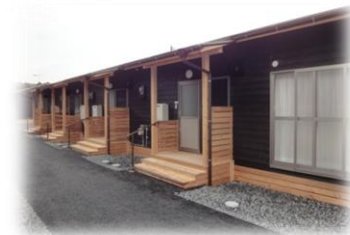
<応急仮設住宅>
