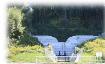
<砂防ダムの設置>
