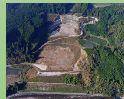
施設が整備された後の状態
