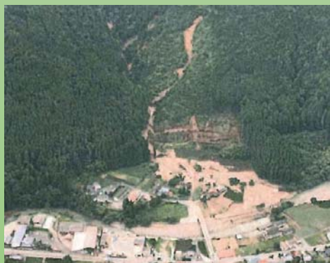
施設が整備されていない状態 (土砂災害発生直後)
