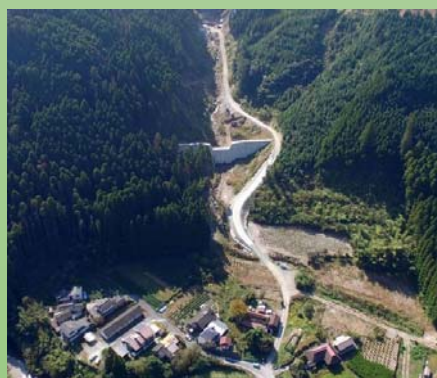
施設が整備された後の状態
