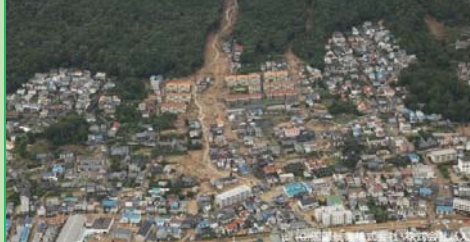
平成26年 広島豪雨災害 (2014年、広島県)
