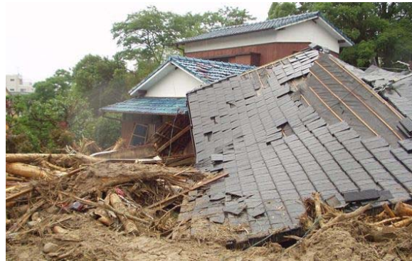
土石流の被害を受けた家の様子
