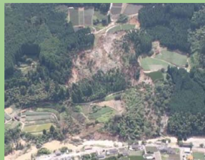
施設が整備されていない状態 (地すべり発生直後)
