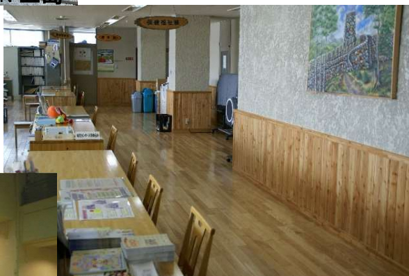
H21役場庁舎内装木質化
