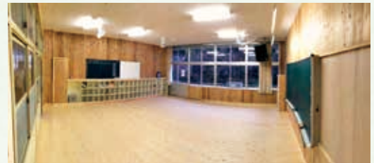
学校教室内木質化(床・壁板作成)
