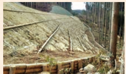
杉円柱加工丸太使用 木製筋工
