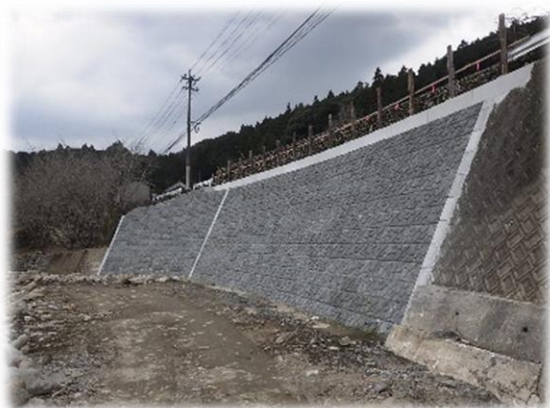
河川の改良工事
