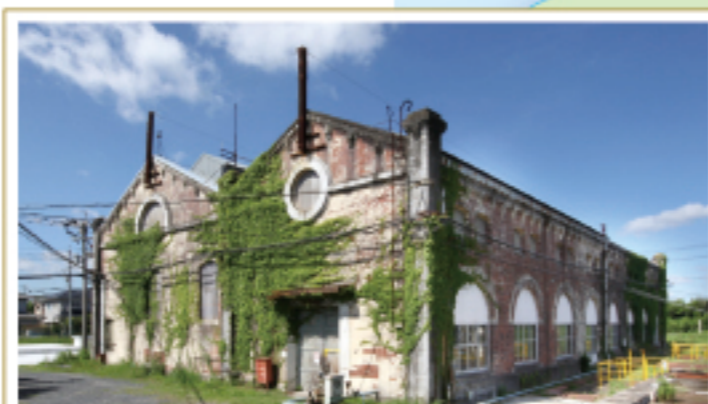
1910年以来、現在も動き続けている製 鐵所の送水施設
