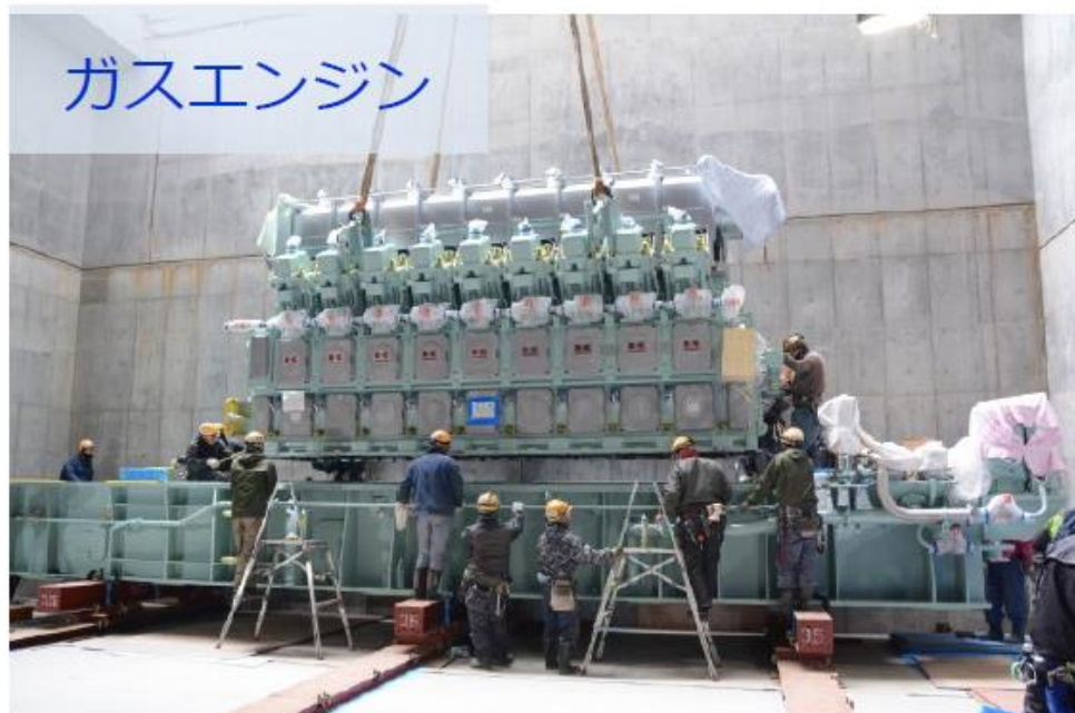
北ガスグループ本社ビルにおける7800kWコージェネ据付工事
