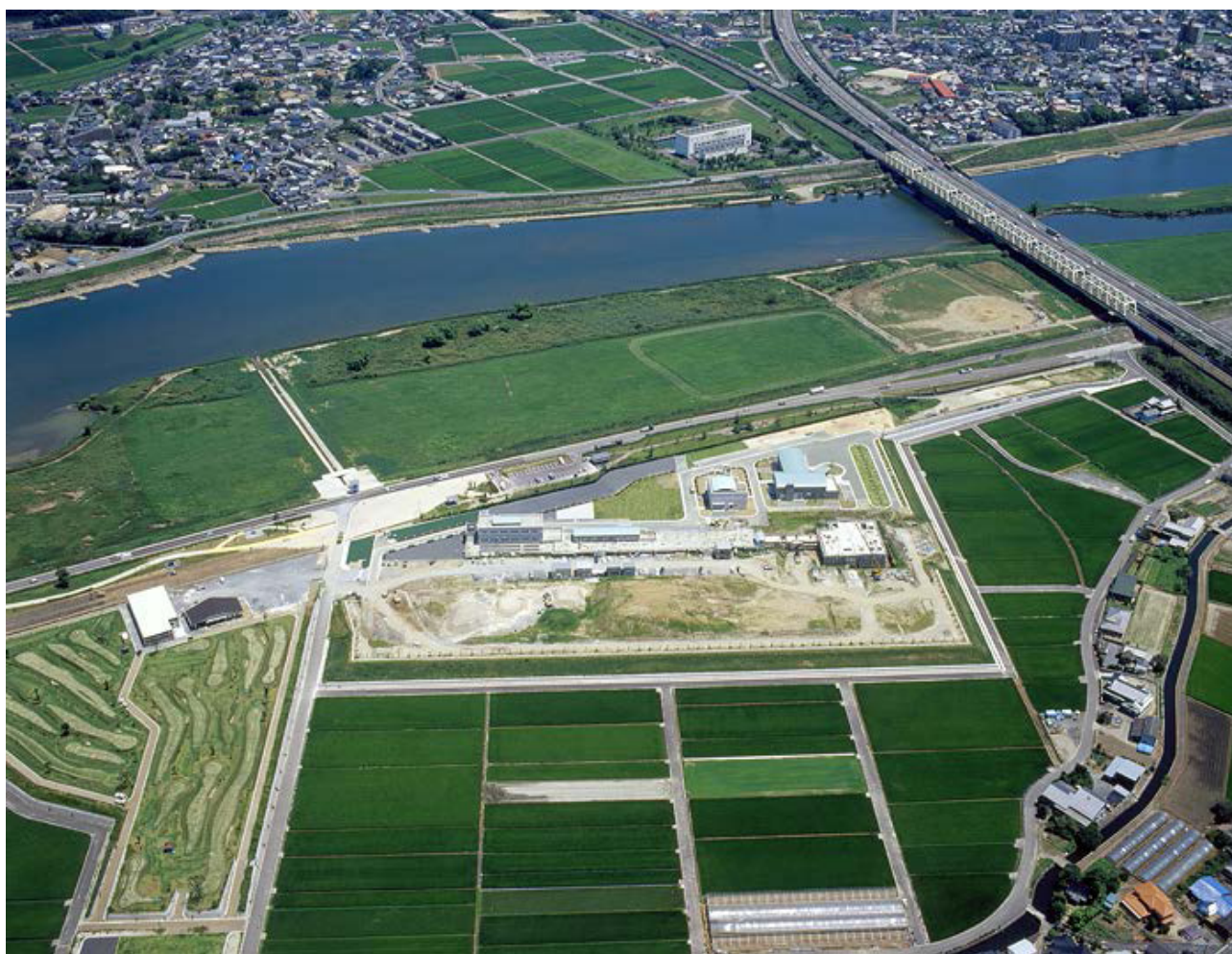
遠賀川中流浄化センター
