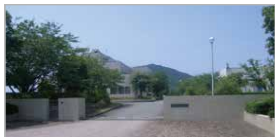
前原下水管理センター(糸島市)
