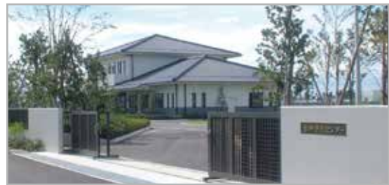
吉井浄化センター(うきは市)
