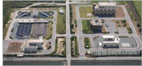
柳川浄化センター(柳川市)
