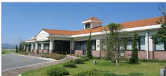
行橋浄化センター(行橋市)
