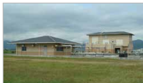
三輪中央浄化センター(筑前町)
