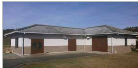
上長田浄化センター(みやま市)
