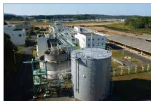
岡垣町浄化センター(岡垣町)
