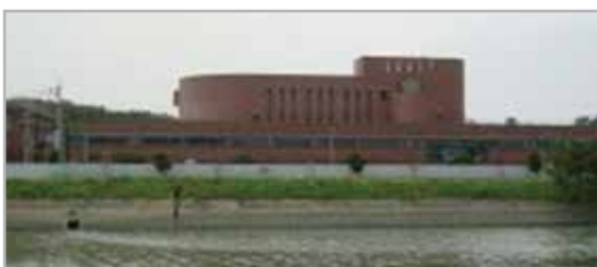
古賀水再生センター(古賀市)
