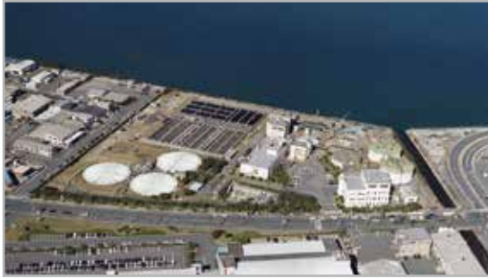
新町浄化センター(北九州市)
