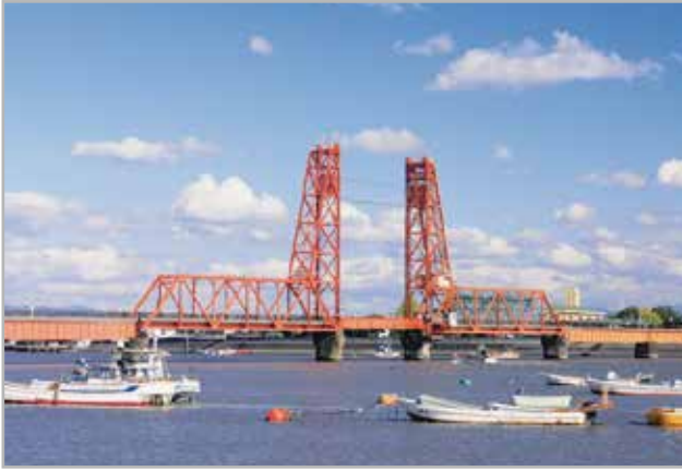
昇開橋(大川市)
