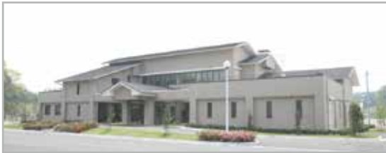
福間浄化センター(福岡市)
