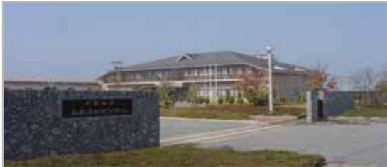
南部浄化センター(大牟田市)
