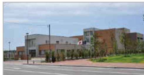
新宮中央浄化センター(新宮町)
