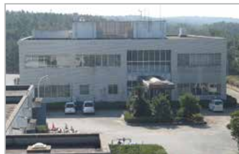
芦屋町浄化センター(芦屋町)
