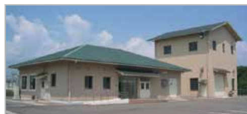
築城浄化センター(築上町)
