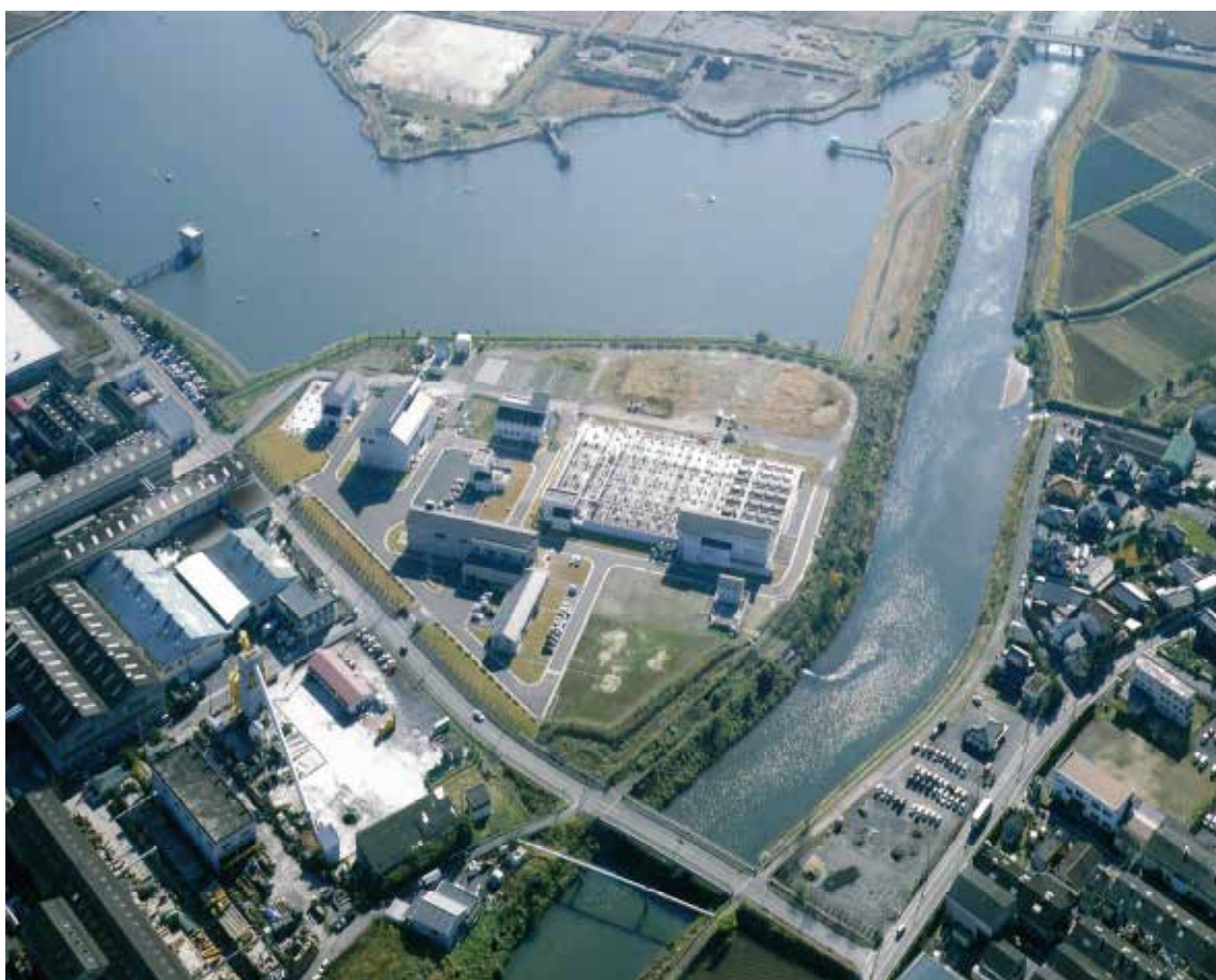
遠賀川下流浄化センター
