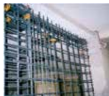
コンクリート壁の新設
