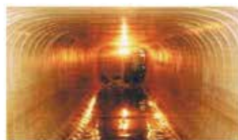
管内面を更生材により被覆した複合管
