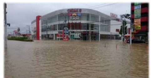
久留米市東合川の浸水状況
