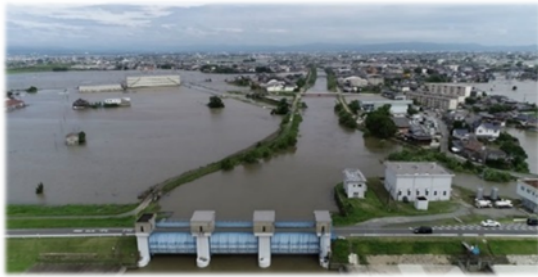
筑後川水系山ノ井川(久留米市城島町付近)
