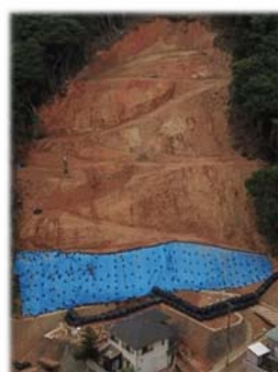
応急復旧状況
