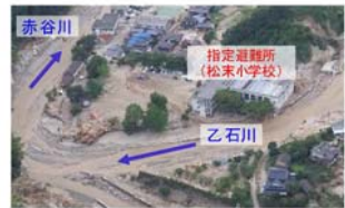
土砂・流木により被災した避難所
