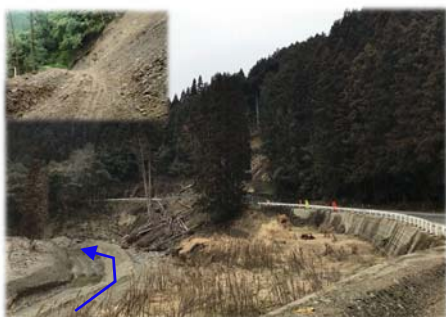
道路啓開状況
