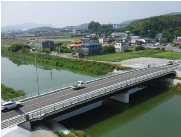
主要地方道 宮田遠賀線 虫生津橋 (遠賀町)
