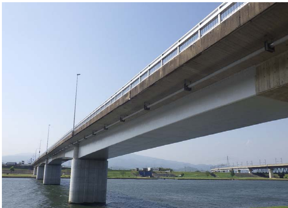
【筑後市】 市道天堤欠塚線 踏切改良事業の事例
