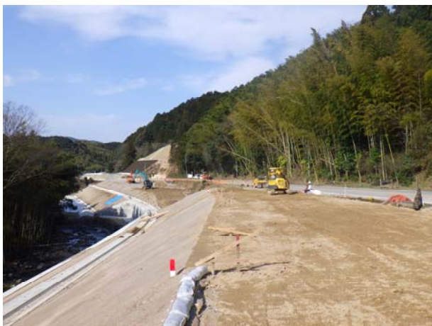
一般国道 322 号 千手バイパス (嘉麻市)
