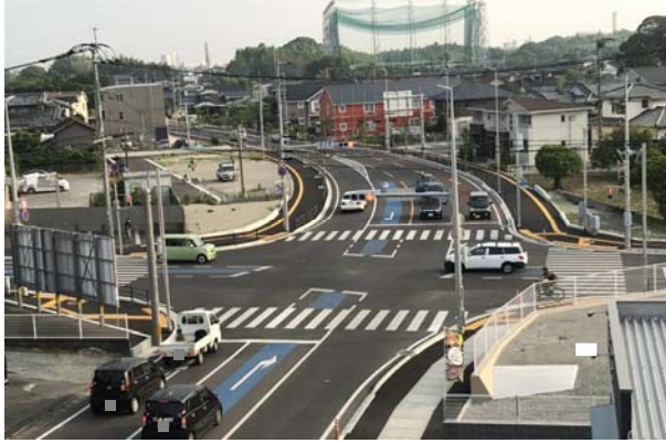
一般県道 藤山国分一丁田線 鎌水工区 (久留米市)
