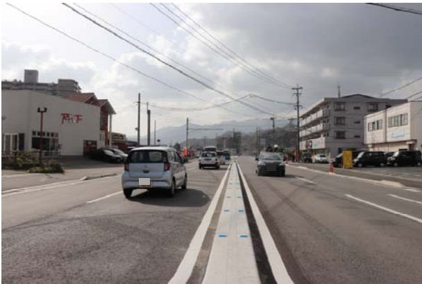
一般国道 385 号 那珂川拡幅・那珂川拡幅Ⅱ期 (那珂川市)
