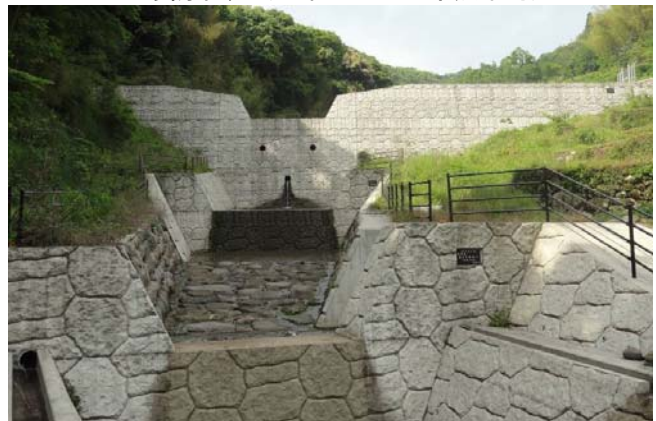
砂防堰堤 (山中川 八女市黒木町)
