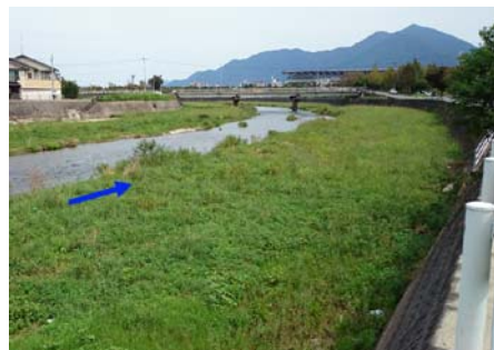
茶屋原堰 (集水埋渠) 平成27年9月の状況
