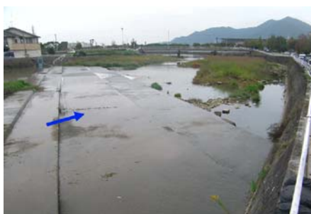
茶屋原堰 (固定堰) 平成23年11月の状況
