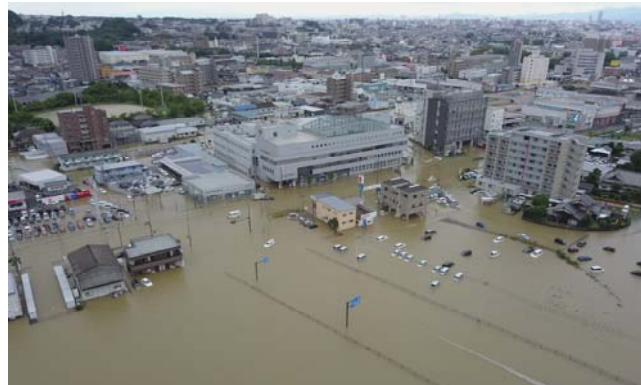
下弓削川（久留米市） 平成30年7月豪雨による災害
