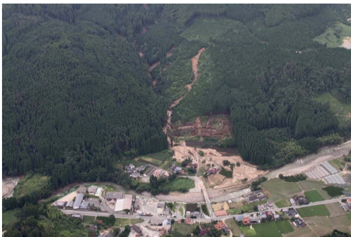
土石流の被害状況
