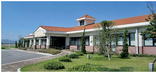
行橋浄化センター（行橋市）
