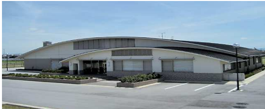
大川市水処理センター 管理棟（大川市）
