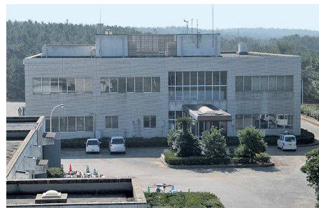
芦屋町浄化センター(芦屋町)
