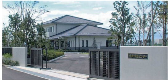
吉井浄化センター（うきは市）
