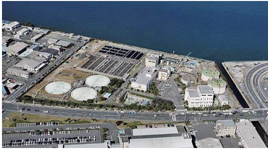
新町浄化センター（北九州市）
