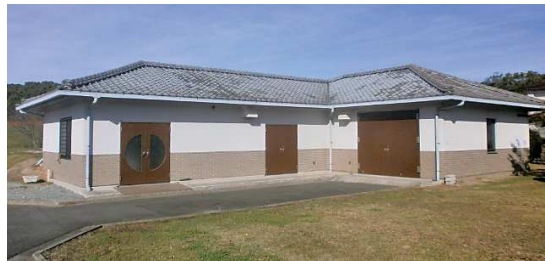
上長田浄化センター（みやま市）
