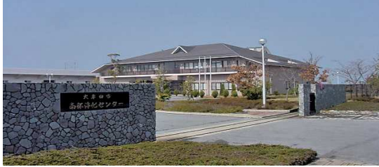
南部浄化センター（大牟田市）
