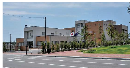
新宮中央浄化センター(新宮町)
