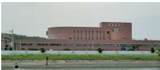
古賀水再生センター（古賀市）
