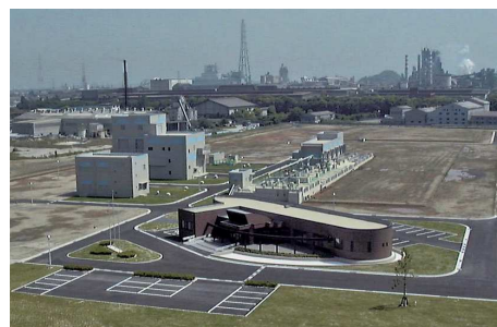
苅田町浄化センター(苅田町)
