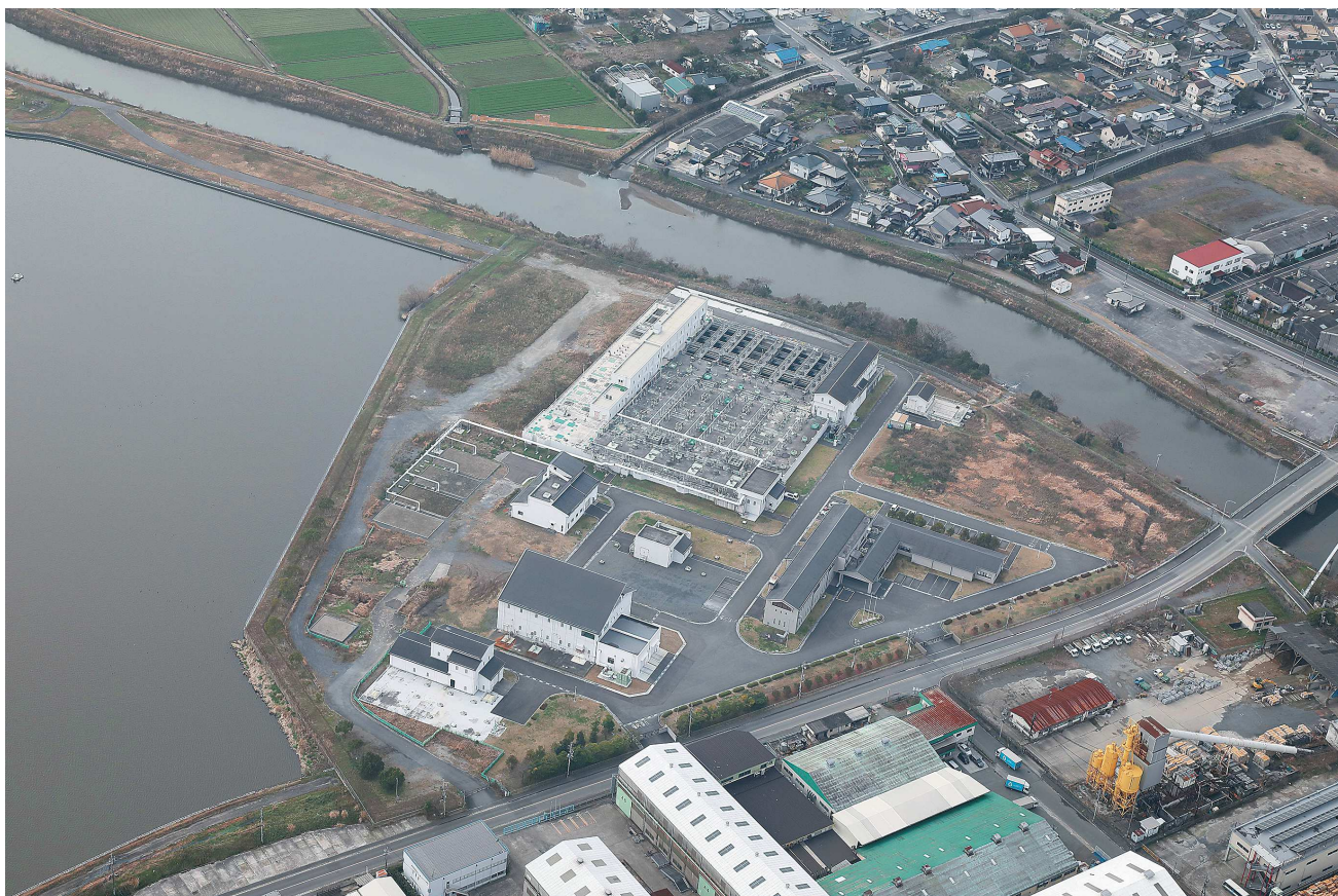
遠賀川下流浄化センター
