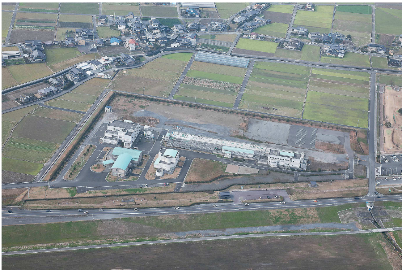
遠賀川中流浄化センター
