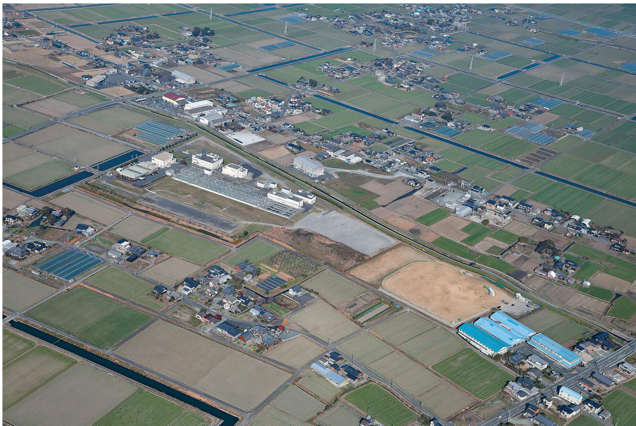
矢部川浄化センター
