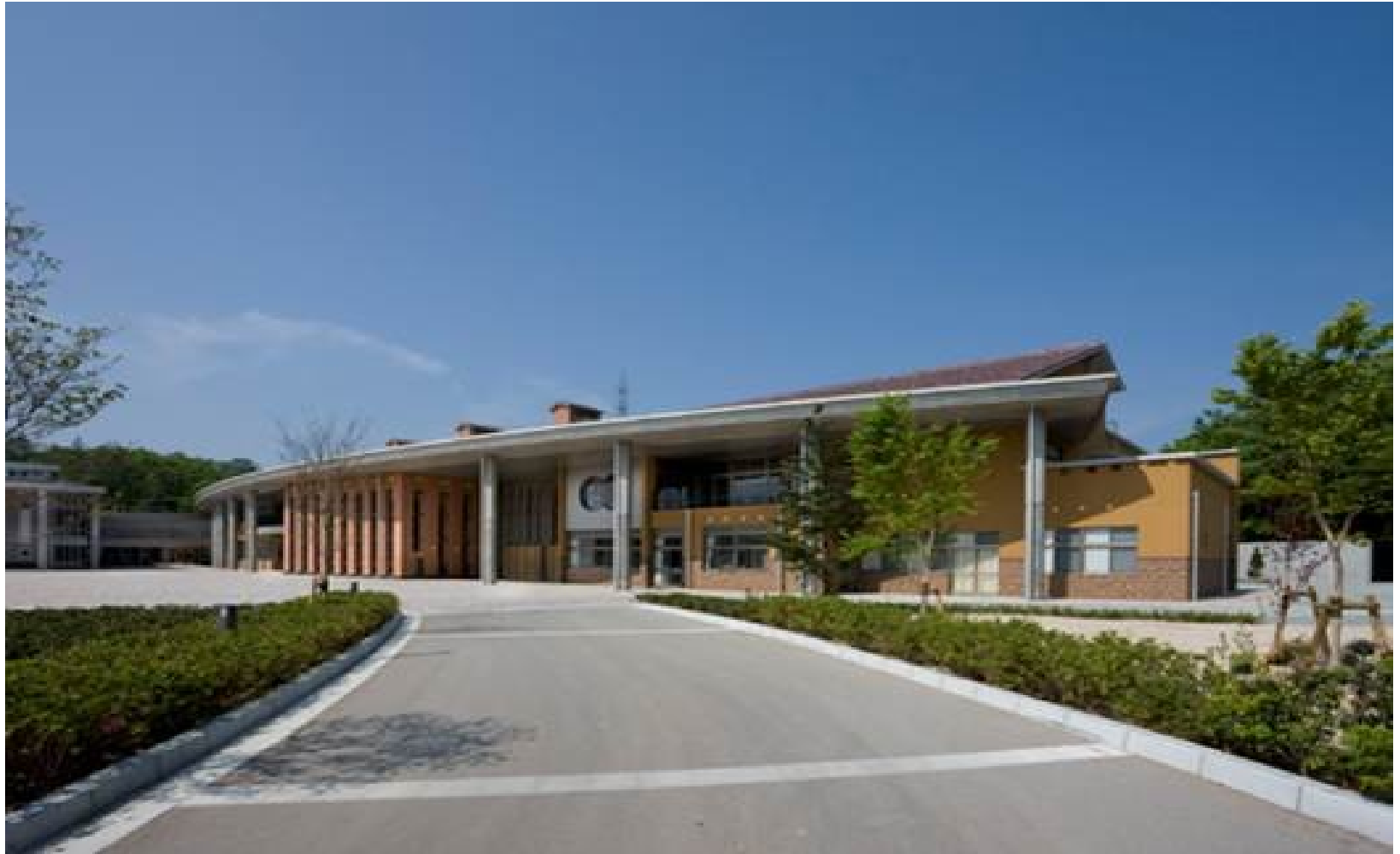
広島県三次市 塩町中学校 平成19年12月完成
