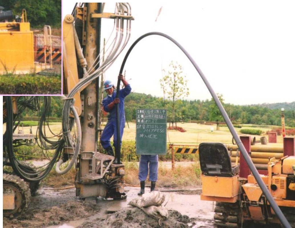
熱交換パイプの挿入
